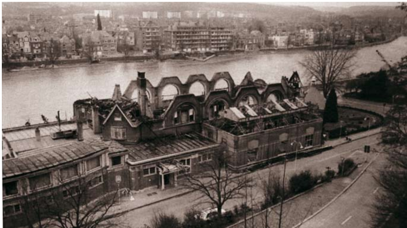
Photo du Casino après l'incendie de 1980. Le bâtiment B et la salle de baccara attenante apparaissent très endommagés. Collection privée.
